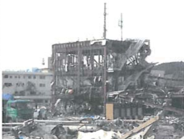
メディアでも注目を集めていた防災対策庁舎も看板と鉄骨だけが残っていました。
